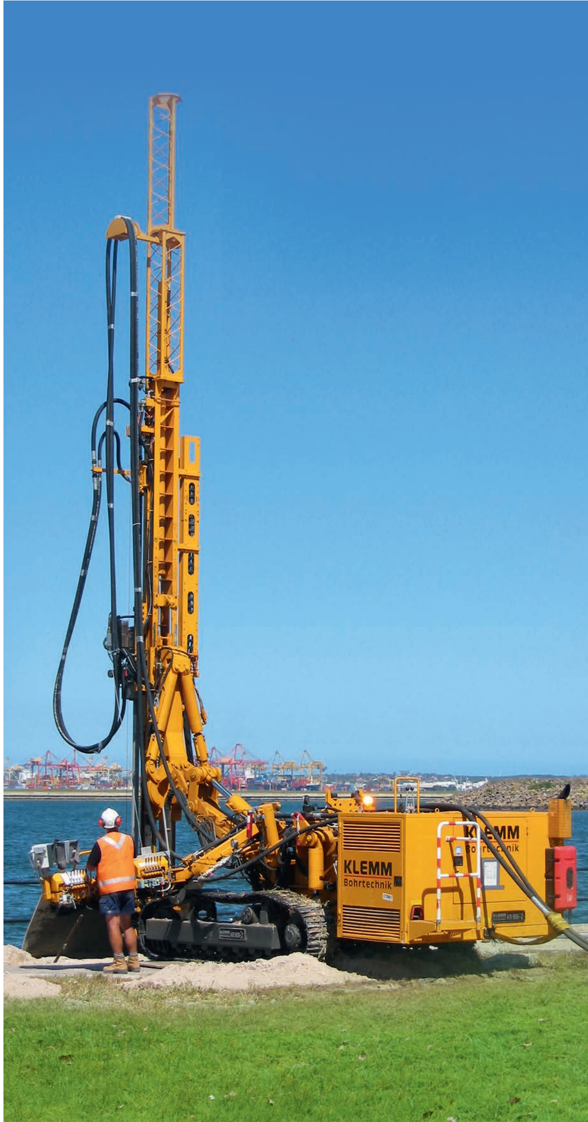
Hochdruckinjektionen High-pressure injections
