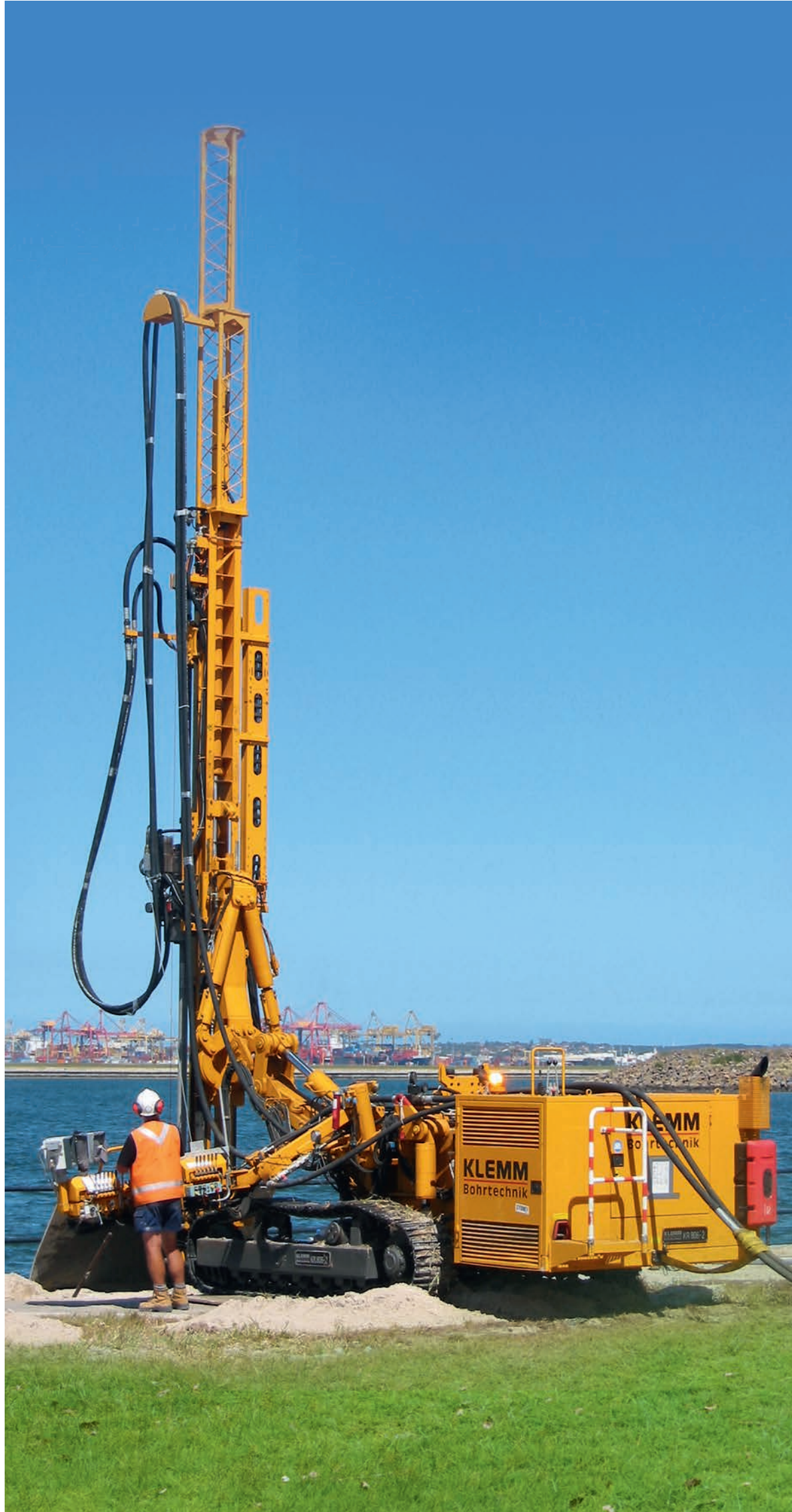
Hochdruckinjektionen High-pressure injections
