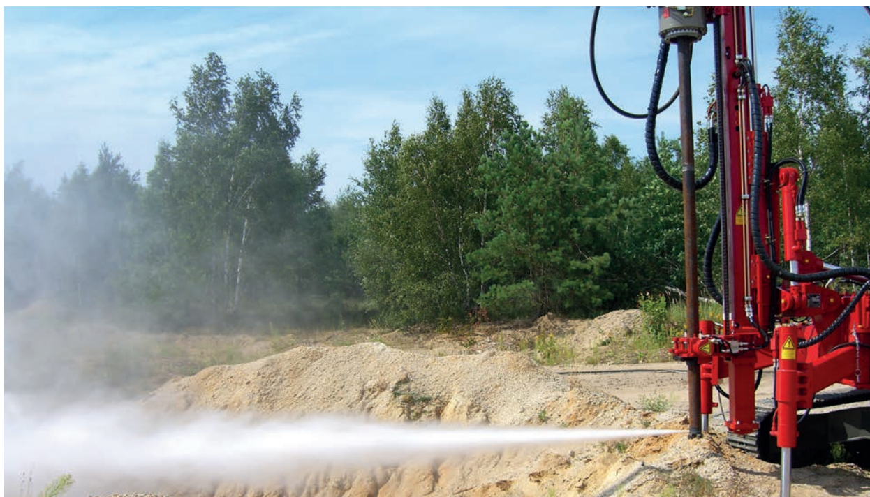
KLEMM HDI-Ausrüstung KLEMM jet grouting system
